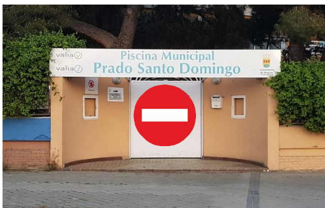
El acceso por la puerta principal (foto superior) no está habilitado.
